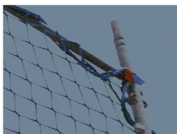
dettaglio anello di aggancio installato
